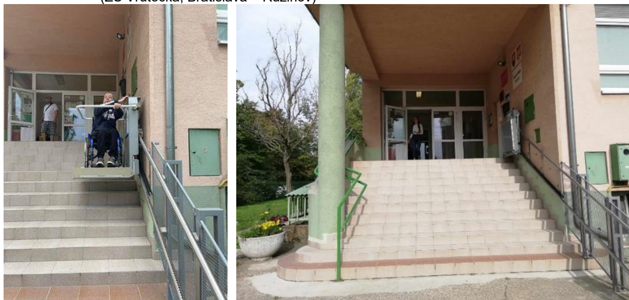
Obrázok 72 Bezbariérový prístup – funkčná zdvíhacia plošina, vhodná pre ľudí odkázaných na invalidný vozík, nie pre ľudí s barlami či rodičov s kočíkmi (ZŠ Vrútocká, Bratislava – Ružinov)
