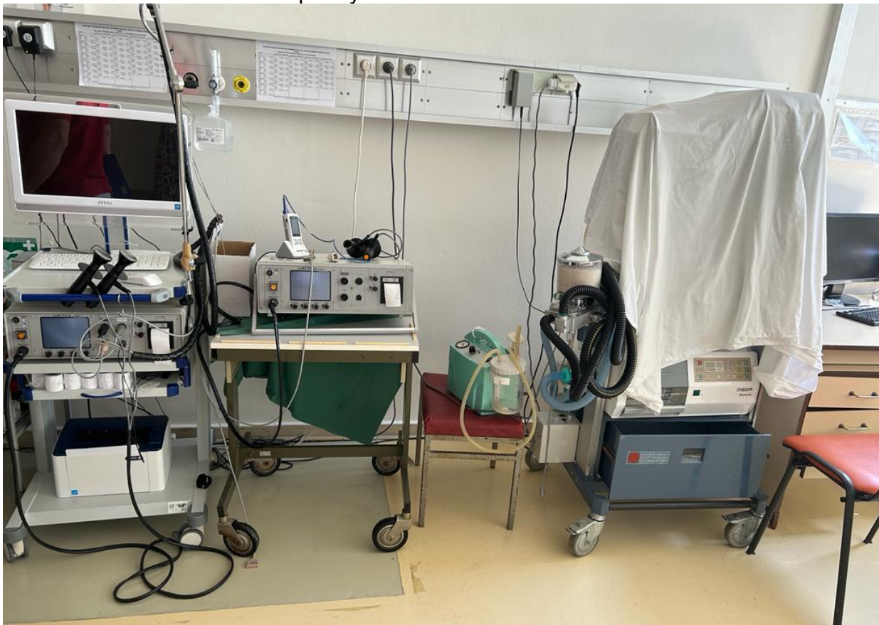
Obrázok 55 Základná sála pre výkon ECT na I. PK Košice
