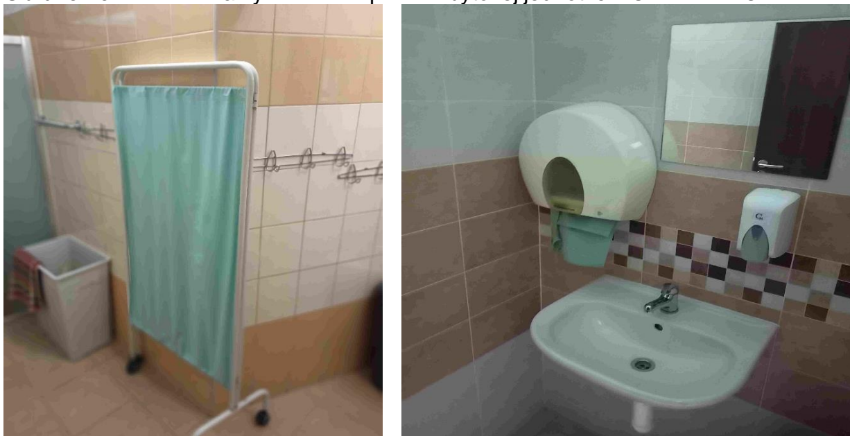
Obrázok 34 Paraván a vybavenie kúpeľne v bytovej jednotke v CSS SYNNÓMIA Žilina
