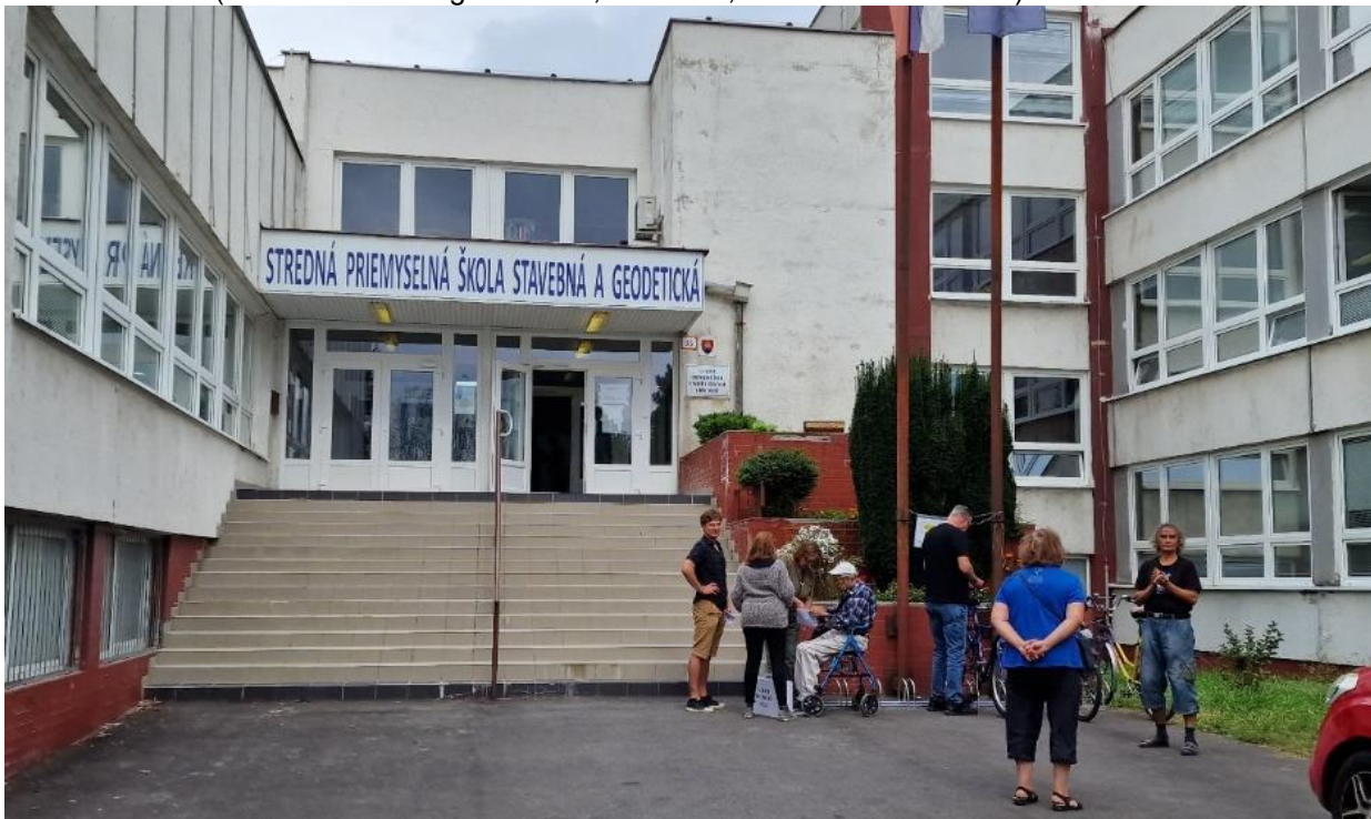
Obrázok 71 Vykonávanie volebného práva pod schodami – nedôstojne, bez zachovania tajnosti hlasovania, bez prístrešku pred zlým počasím (SPŠ Stavebná a geodetická, Drieňová, Bratislava – Ružinov)
