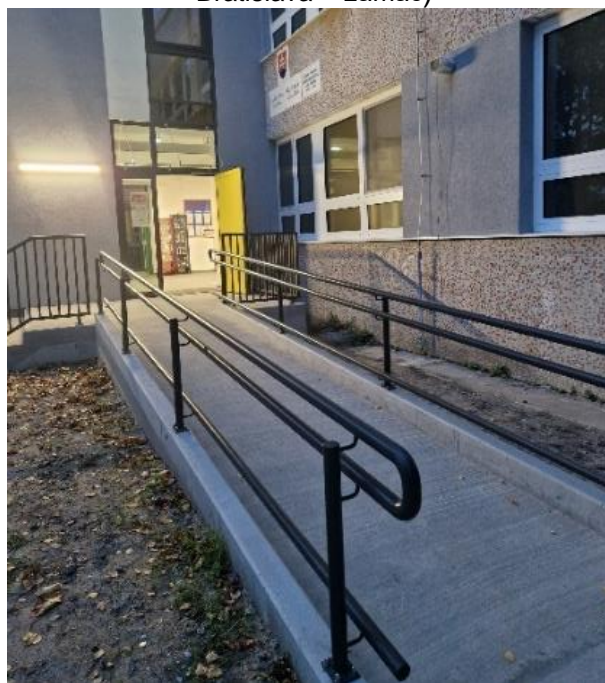
Obrázok 73 Vhodný bezbariérový prístup (nájazdová rampa) do budovy s volebnými miestnosťami (ZŠ Malokarpatské námestie 1, Bratislava – Lamač)
