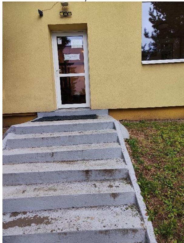
Obrázok 60 Nevyhovujúci bariérový vstup bez nájazdovej rampy, zábradlia, s vysokým prahom a úzkymi dverami (ZŠ s MŠ bl. Petra Pavla Gojdiča, Prešov)
